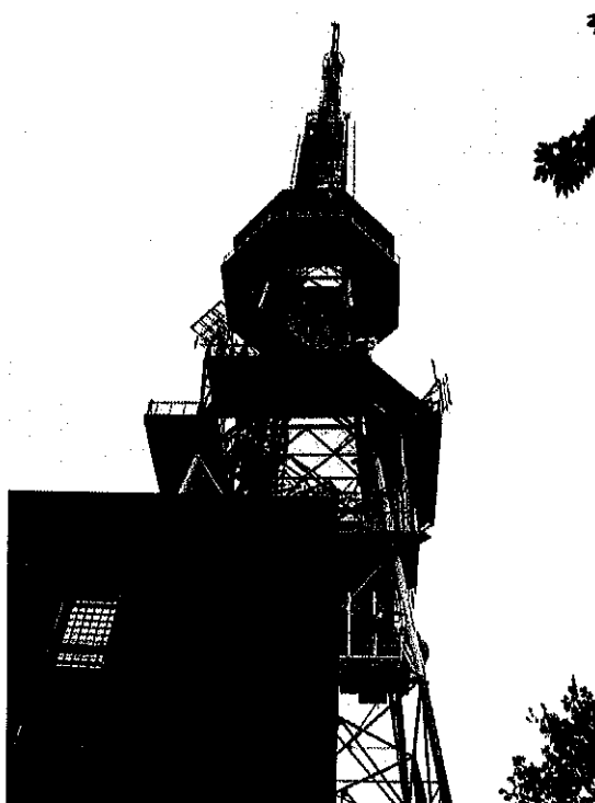
Zoł. nr 1: Widok ogólny instalacji radiokomunikacyjnej.
