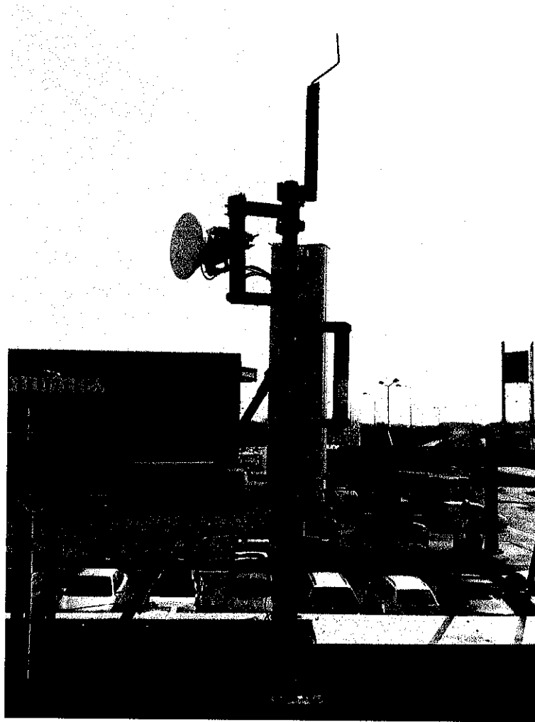
Zal. nr 1: Widok ogólny instalacji radiokomunikacyjnej.
