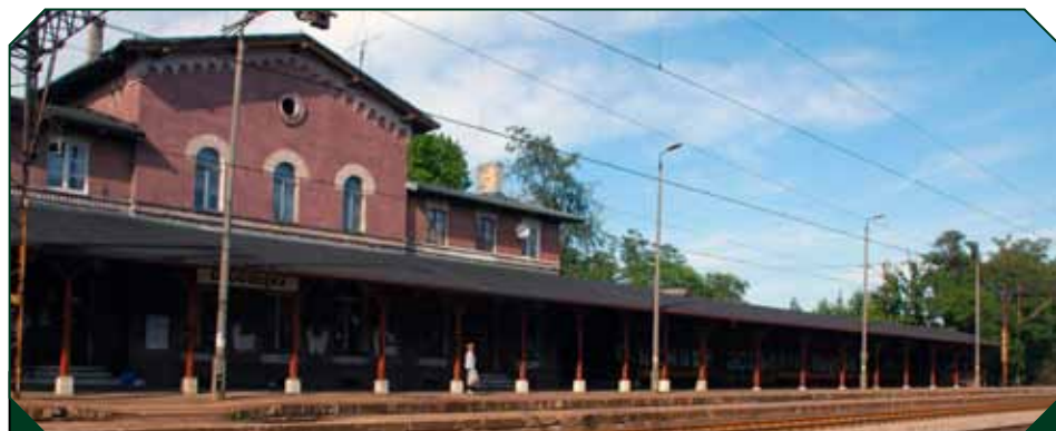
Stacja kolejowa w Długołęce. W roku 1868 uruchomiono linię na trasie Wrocław-Oleśnica przez Długołękę. Ze względu na gości i tłumy zwiedzających rezydencję królów saskich w Szczodrem linia ta cieszyła się dużą popularnością.
