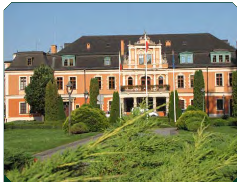
Dawny barokowy pałac po przebudowie stał się częścią nowej reprezentacyjnej rezydencji w modnym w XIX wieku stylu historycznym.
