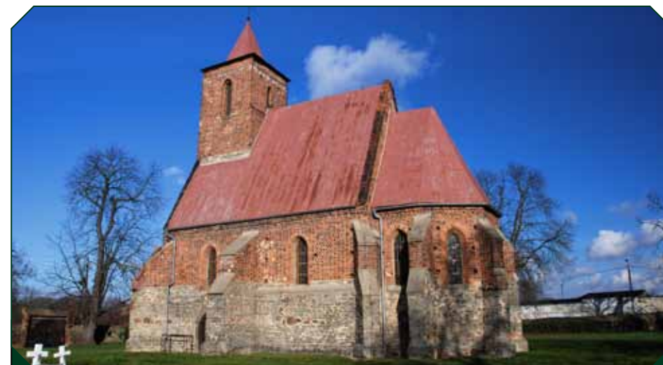
Kościół w Wilczkowie zbudowany został na solidnym kamiennym fundamencie. W czasie wojny trzydziestoletniej otoczono świątynię ceglonym murem ze strzelnicami.
