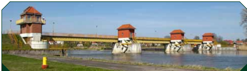
Trzyprzęsłowy Jaz Ratowice na rzece Odrze, powstały w 1914 roku, to jeden z całego ciągu stopni, dzięki którym utrzymywany jest wymagany poziom wody na rzece.
