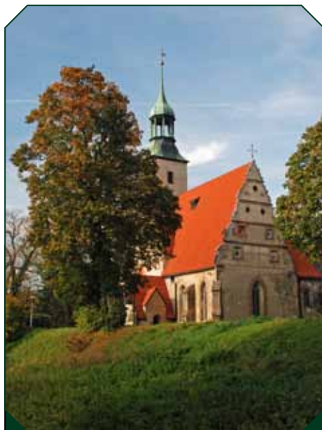
Manierystyczny kościół położony na wyspie, na którą prowadziły dwa zwodzone mosty, ze względu na obronny otoczenie był ziemnymi fortyfikacjami.
