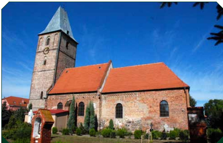
Kościół pw. św. Katarzyny jest świątynią orientowaną (prezbiterium skierowane na wschód), z nieotynkowanej (częściowo gotyckiej) cegły.
