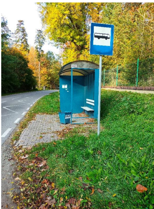
Foto 4 – Przystanek autobusowy nr 1
