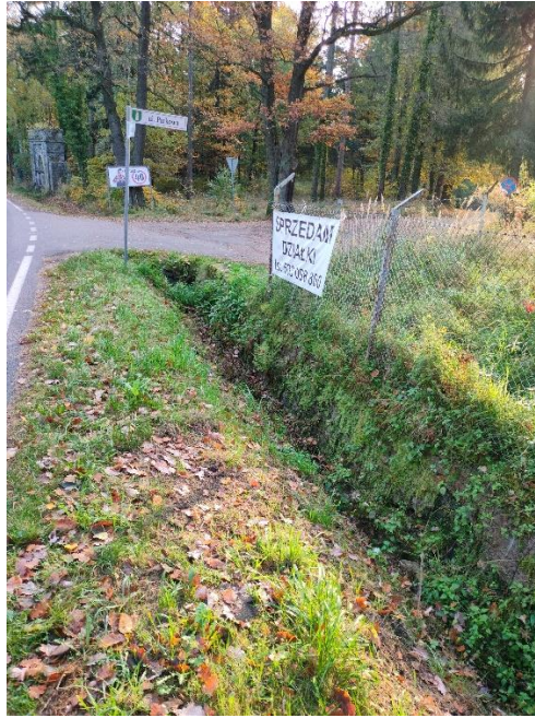
Foto 2 – Rów przydrożny i skrzyżowanie z ul. Parkową
