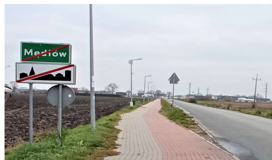
Zdjęcie 22. Droga pieszorowerowa, Mędłów, ul. Sosnowa (Źródło: fotografia wroSIP; https://serwis.wrosip.pl/imap/?gmap=gp0 (12.10.2022 r.))
