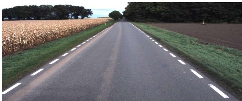
Zdjęcie 26. Droga powiatowa nr 2075D na odcinku Jordanów Śląski – Tyniec nas Ślęzą (Źródło: fot. własne)
