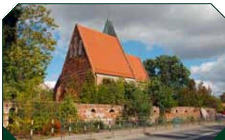
W Jaskotlu w ceglany murze na fundamencie z kamieni polnych o wysokości ponad 2,5 metra widoczny jest rząd strzelnic o wylotach na przemian okrągłych i rombów. Południową furtę prowadzącą na przykościelny cmentarz zdobi attykowy szczyt.
