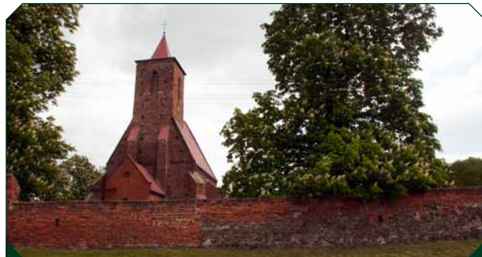
Gruby na pół metra mur obronny przy kościele w Wilczkowie zbudowano na kamiennym fundamencie w okresie wojny trzydziestoletniej, oblicowano cegłą, a jego wnętrze wypełniono kamieniem polnym. Zachowały się strzelnice (obecnie na wysokości 0,3 metra) o prostokątnym wylocie.
