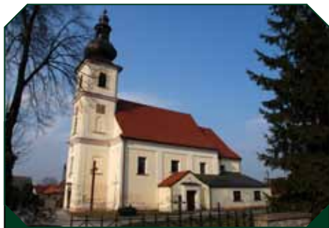
Świątynia w Długotłęce pod wezwaniem Michała Archaniola jest jednonawowym, orientowanym kościołem z prosto podzieloną elewacją i czworoboczną wieżą, w której usytuowano główne wejście.
