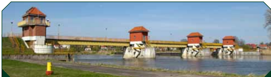
Trzyprzęsłowy Jaz Ratowice na rzece Odrze, powstały w 1914 roku jest jednym z całego ciągu stopni, dzięki którym utrzymywany jest wymagany poziom wody na rzece.
