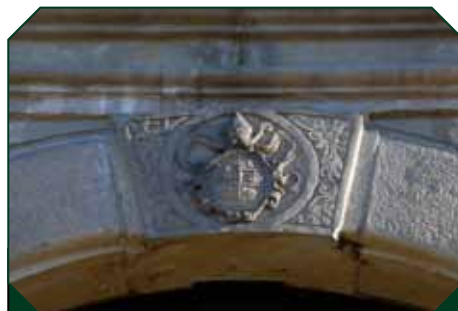
Główne wejście zdobi manierystyczny portal z herbem opata premonstratensów - Scultetusa, który na początku XVII wieku wzniośł murowany dwór.
