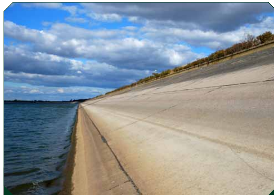
Ziemno-betonowa tama ma ponad trzy kilometry długości i siedemnaście metrów wysokości.
