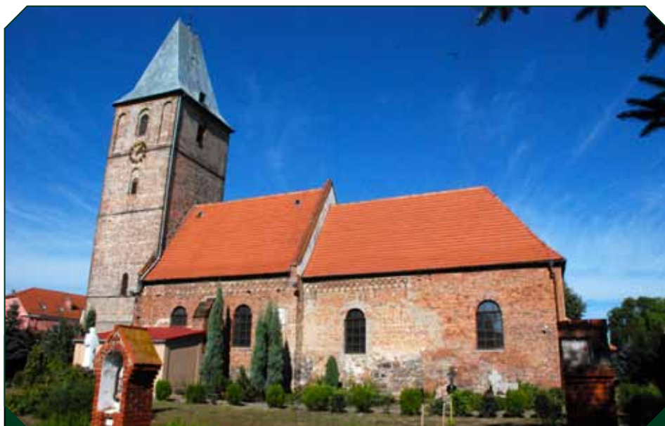
Kościół p.w. św. Katarzyny jest świątynią orientowaną (prezbiterium skierowane na wschód), z nieotynkowanej (częściowo gotyckiej) cegły.
