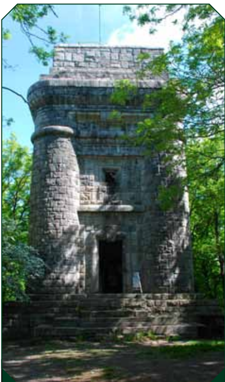
Piętnastometrowa wieża na Wieżycy wybudowana została z granitowych ciosów z narożnikami w kształcie okrągłych baszt. Na środku otoczonego kamienną balustradą tarasu widokowego znajdowała się pierwotnie misa ogniowa.
